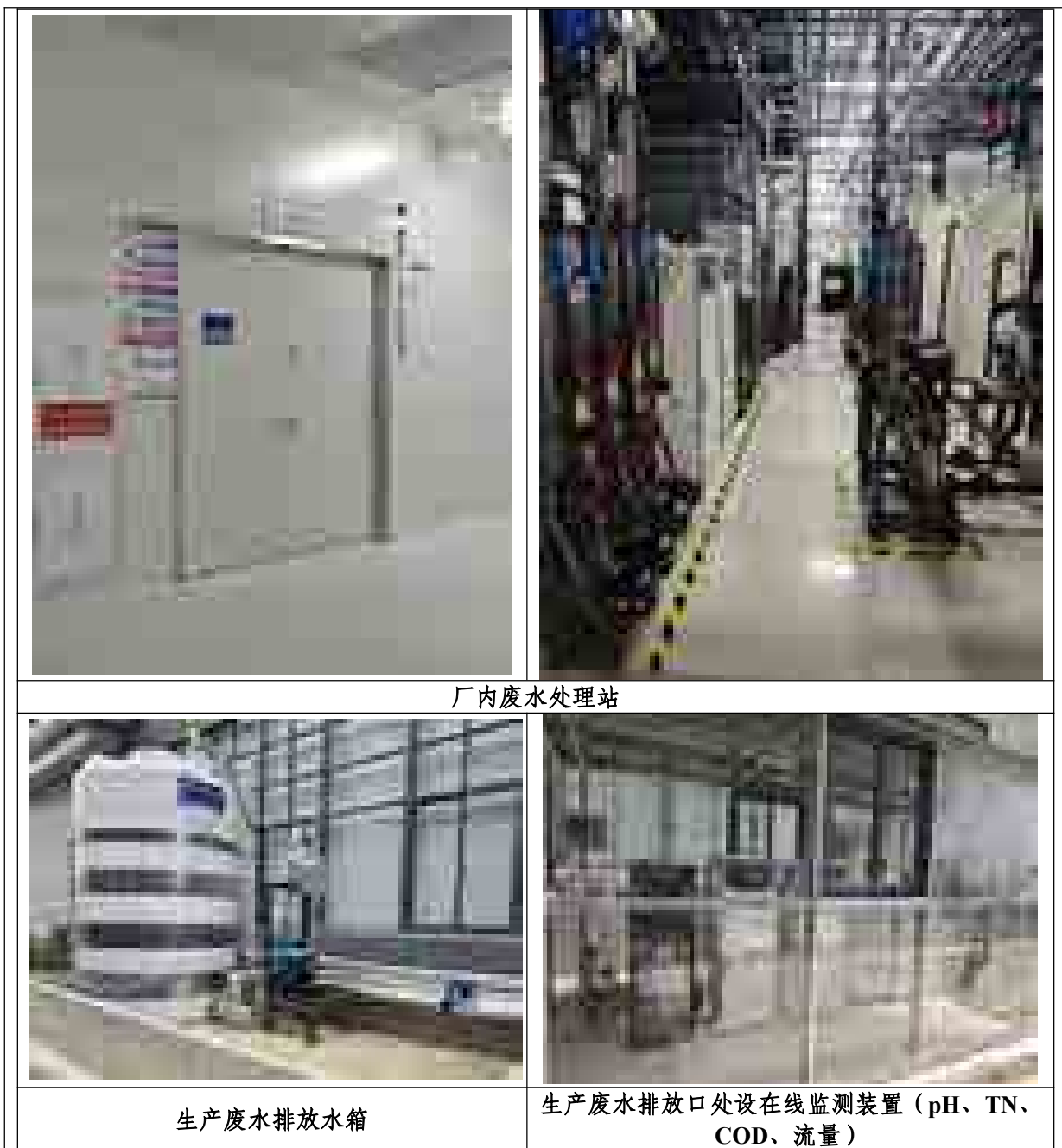
图3-2 废水处理设施及排放口现场照片
